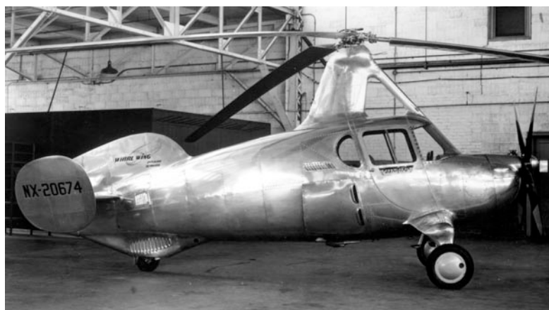
Il Pitcairn Pa. 36 biposto anch'esso destinato al decollo "al salto". Interamente metallico poteva viaggiare anche su strada come il predecessore AC 35 una volta piegate le pale verso coda.
