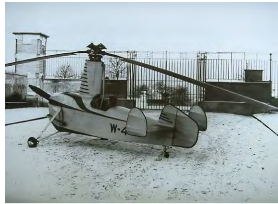
Lo sfortunato Weir W-4 che si distrusse in prova (Internet) The unlucky Weir W-4 lost during a test.
