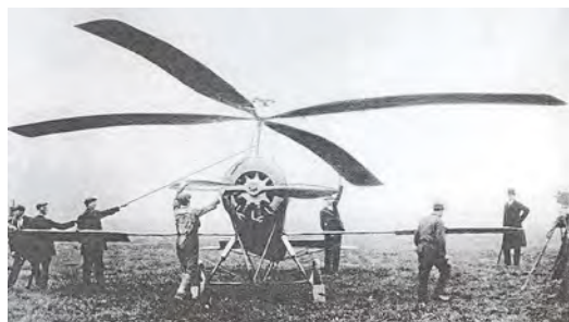
Il C.6 A pronto al decollo. Si notino i "volonterosi" muniti di fune (a sinistra) per la prerotazione
